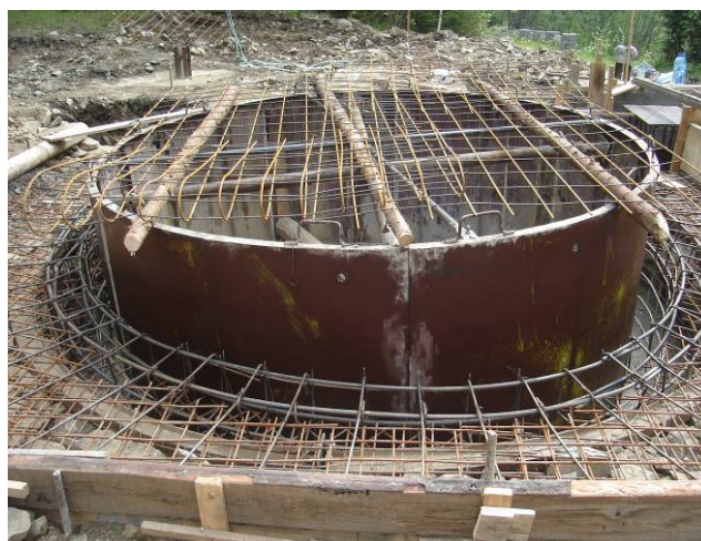
Fig.3: Gulerul puțului Netiș executat în material de umplură rezultat din: rocă cu argilă din deluviu de pantă
