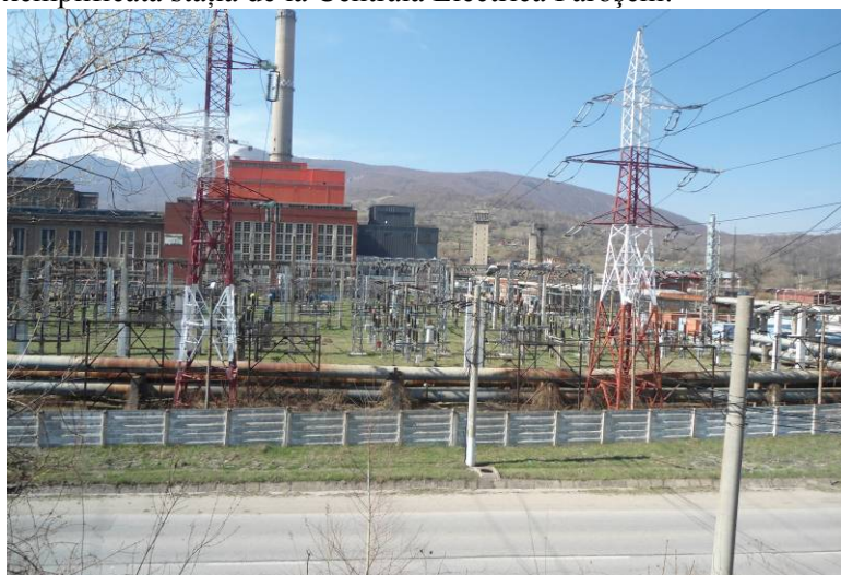
Figura 1: Stația de 110/220 kV de la Paroșeni
